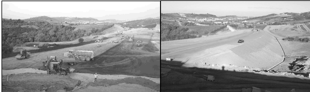
Figura 4 - Fases de execução do aterro localizado entre os kms 2+925 e 3+225 do trecho 1
