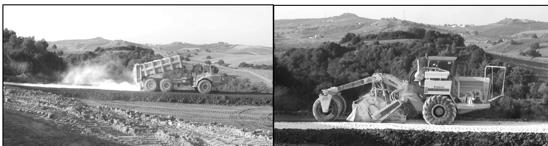
Figura 6 - Fases de colocação e mistura das margas tratadas com cal
